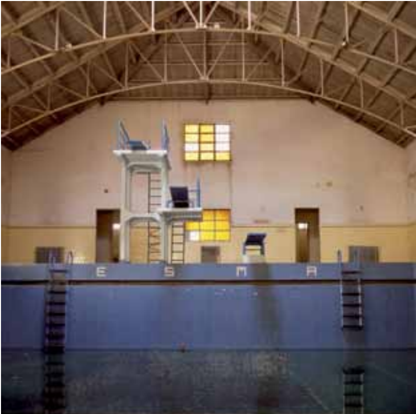
Pileta de Natación.
